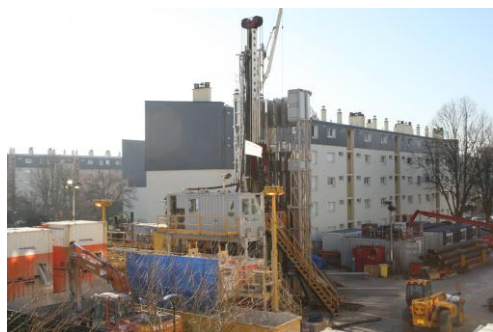
Chantier de forage, Square Fleming Crédit photo : Hauts-de-Seine Habitat)
